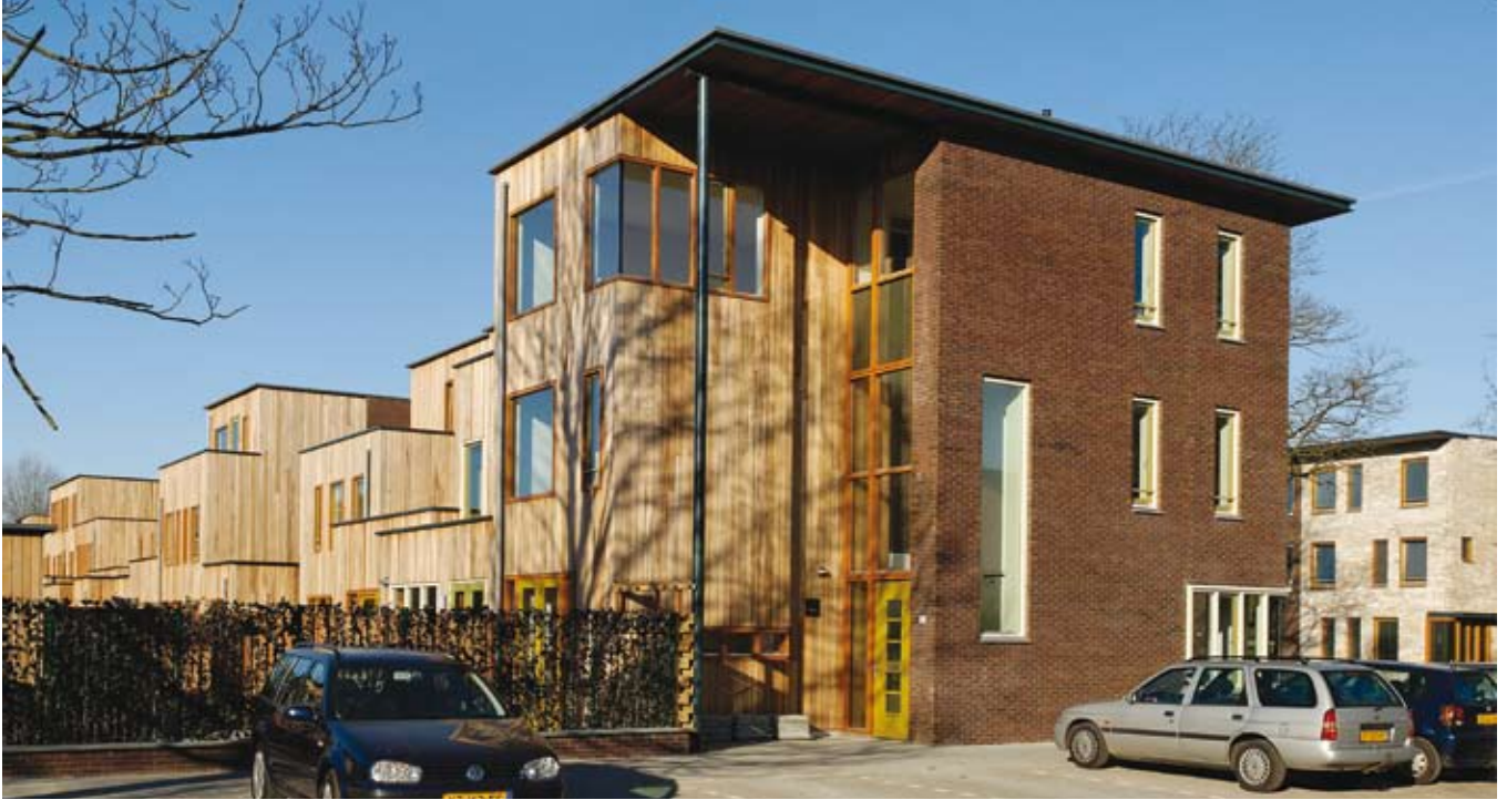
De achterzijde is van hout, en kan ook later worden uitgebreid - foto Rob 't Hart
